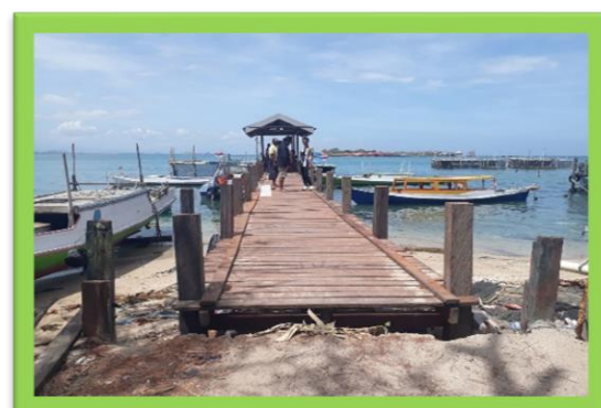
Pembangunan Pelabuhan Pengumpan Lokal
