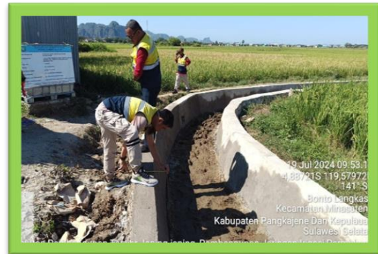
Pembangunan Jaringan Irigasi
