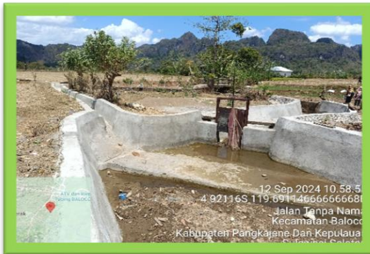
Rehabilitasi Bendungan Irigasi
