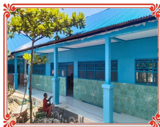
Pembangunan Ruang Kelas Baru
