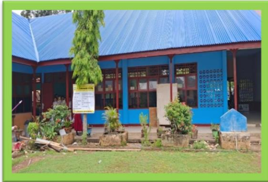
Pembangunan Ruang Kelas Baru
